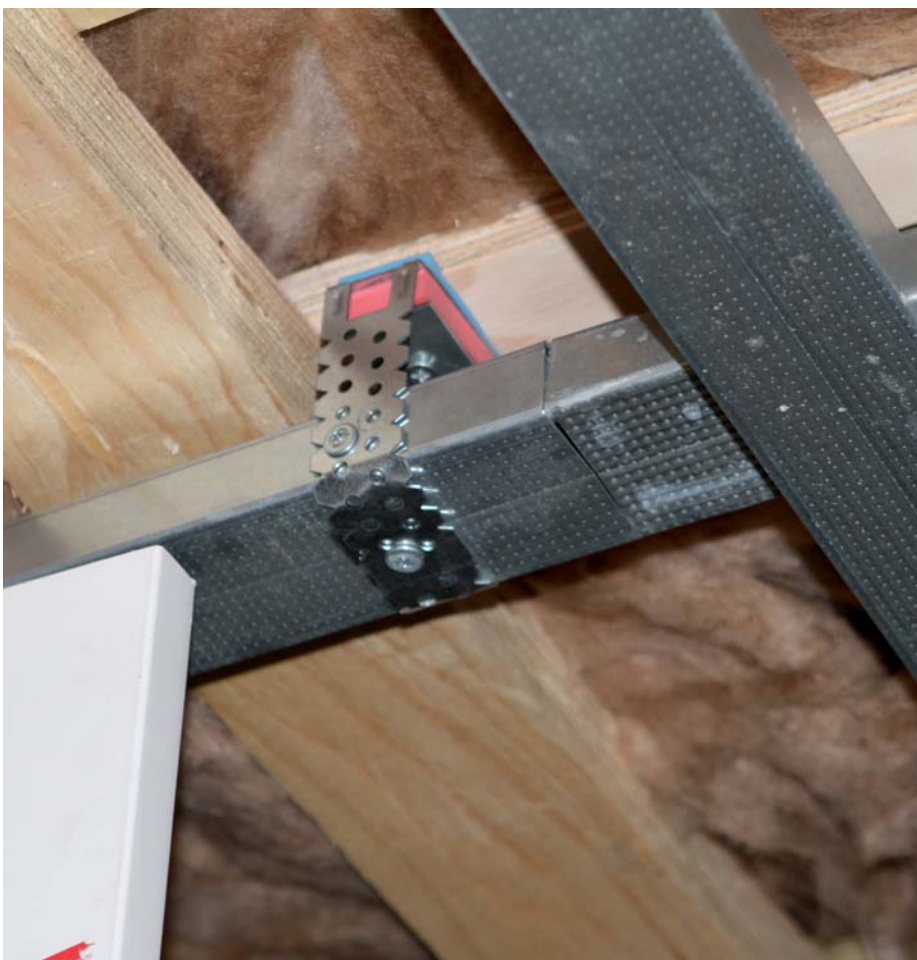
De constructie van staal en houtskelbouw heeft van zichzelf te weinig massa om geluid voldoende te isoleren.
