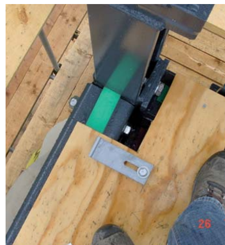
Voor het akoestisch ontkoppelen paste de aannemer verschillende soorten oplegvilt toe.
