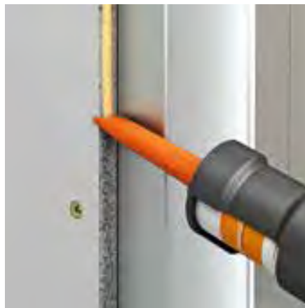
fermacell lijmvoeg – voegbreedte: 0.5 - 1 mm
