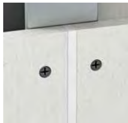
fermacell gipsvoeg – voegbreedte: \frac{1}{2} \times plaatdikte
