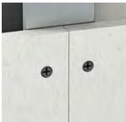
Platen stotend gemonteerd – voegbreedte \leq 1 mm
