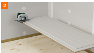
Sciage du joint pour la première rangée de panneaux
