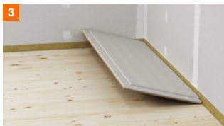
Pose du premier élément
