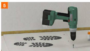
Vissage du joint...
