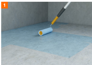
1 Apprêter le support et poser les bandes isolantes latérales en laine de roche.
