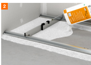
Étalement du granulat
