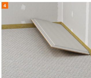
4 Poser les plaques de sol fermacell®
