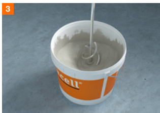
3 Dans un seau propre, mélanger 6,5 l d'eau par sac de 25 kg.
