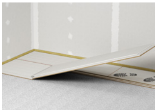
Pose des Plaques de sol fermacell®
