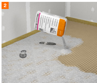
2 Remplir la plaque nid-d'abeilles fermacell™ de Granules pour nid d'abeilles fermacell™
