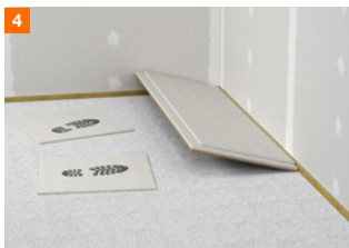
Pose des Plaques de sol fermacell®
