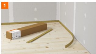
Application de la bande périphérique
