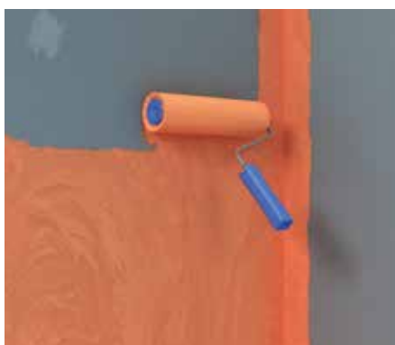
Afb. 6: fermacell Vloeibare folie met de rol 2 x volvlaks aanbrengen (totale dikte \geq 0,5 mm)
