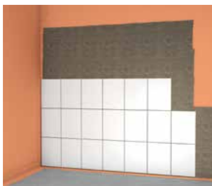
Afb. 7: Tegels worden geplaatst met een dunne laag fermacell Flexibele tegellijm op een volvlaks-afdichting (garandeert de afdichting voor de vochtbelastingsklasse A).
