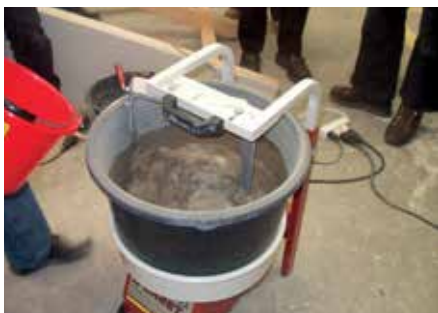
fermacell Expanderende mortel aanmaken
