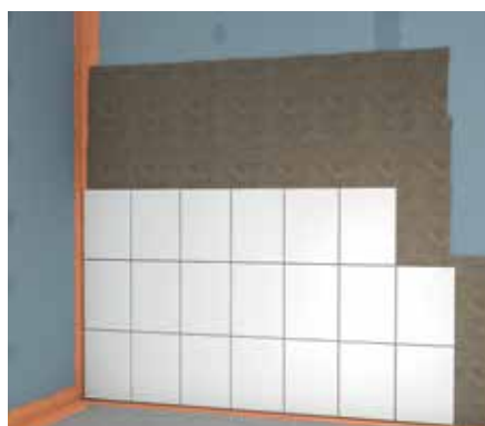
Afb. 5: Bij gebruik van Powerpanel H 2 O platen binnen woonsituaties. Tegels worden in een dunne laag fermacell Flexibele tegellijm geplaatst (garandeert de afdichting voor de vochtbelastingsklasse A01).
