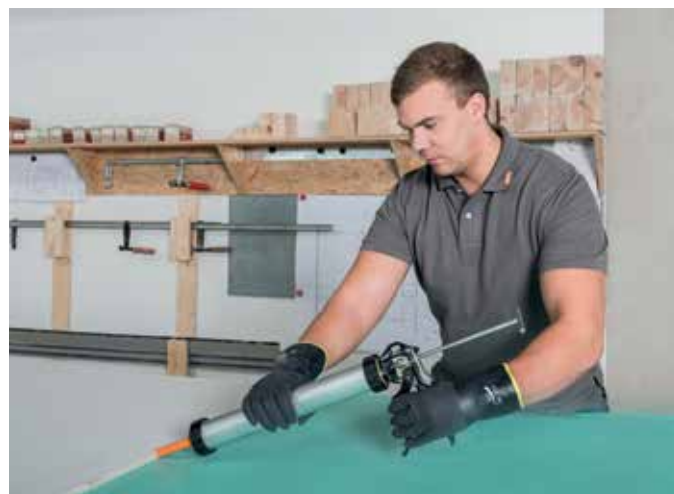
Opbrengen van de fermacell Voegenlijm in worsten van 580 ml.
