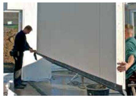
Wandplaat in mortelbed neerzetten
