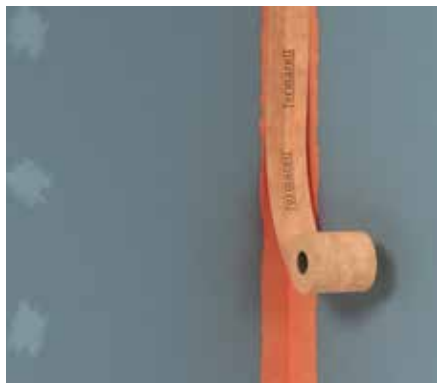
Afb. 2: fermacell Afdichtband aanbrengen in de eerder aangebrachte, nog vochtige laag fermacell Vloeibare folie en meteen afsmeren met Vloeibare folie
