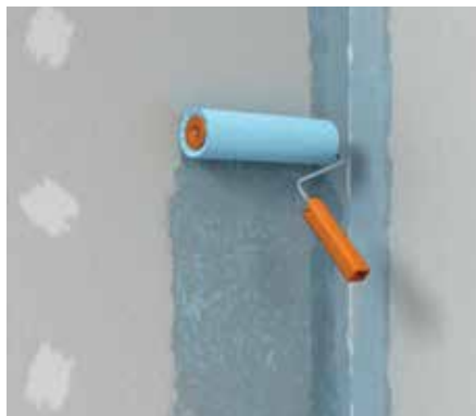
Afb. 1: fermacell Diepgrond aanbrengen op het hele oppervlak
