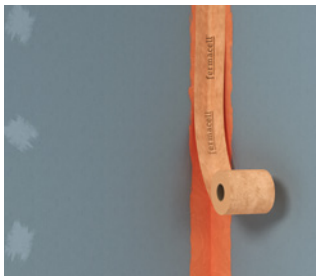
fermacell™ Afdichtband aanbrengen in de eerder aangebrachte, nog natte laag fermacell™ Vloeibare folie ...
