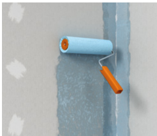
fermacell™ Diepgrond aanbrengen op het hele oppervlak
