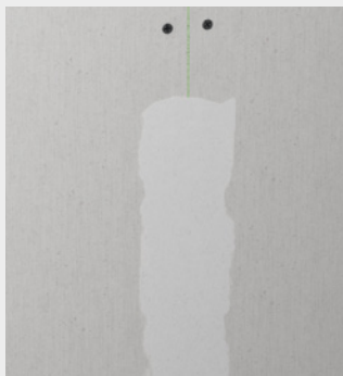
Deels afgewerkte lijmvog
