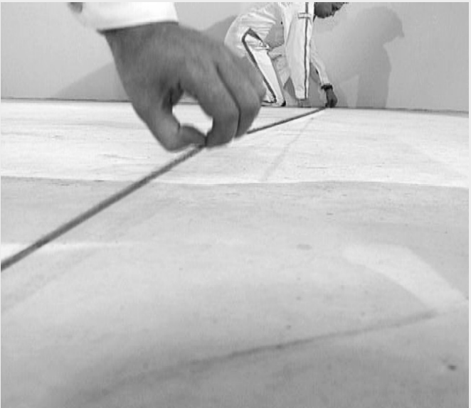
Het aftekenen van de wandassen met smetlijn of bouwlasers
