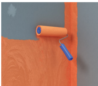
fermacell™ Vloeibare folie met de rol 2 x volvlaks aanbrengen (totale dikte \geq 0,5 mm)
