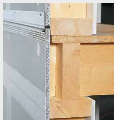
Afbeelding 4.15: Gemonteerde plaatstrook met fermacell Powerpanel HD Vloeraansluitingsprofiel
