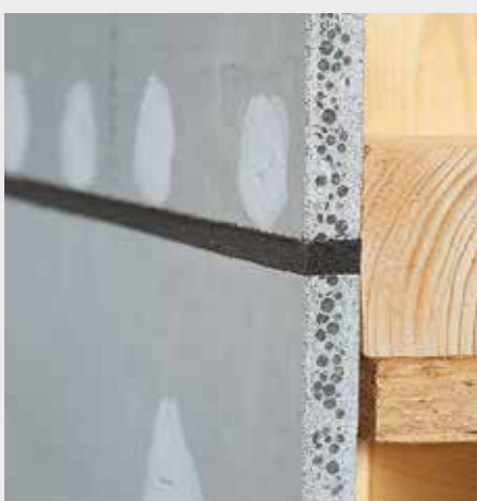
Afbeelding 4.13: Voorgecomprimeerd afdichtingsband voor tijdelijke bescherming tegen weersinvloeden
