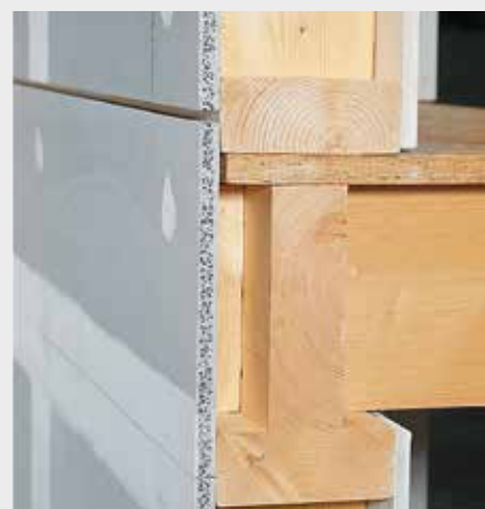
Afbeelding 4.12: Plaatstrook afgewerkt aan de onderzijde met de voegtechniek
