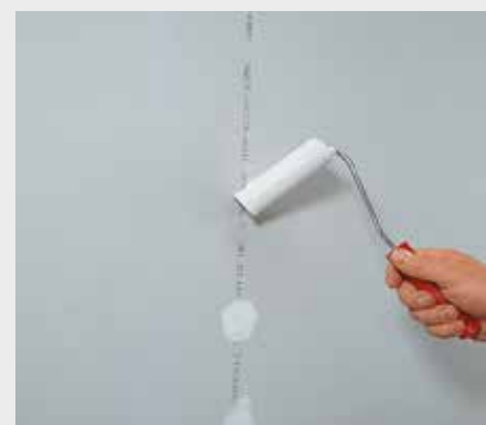
Afbeelding 3.15: Dekkend aantippen van de verbindingmiddelen ter plaatse van de middenstijl
