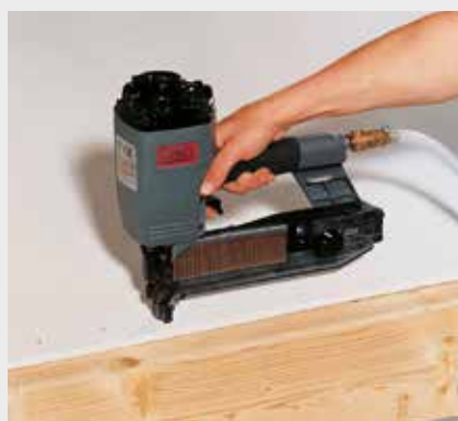
Afbeelding 3.9: Manuele bevestiging met pneumatische tacker
