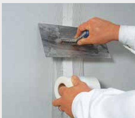
Afbeelding 3.13: Aanbrengen van de fermacell Powerpanel HD Wapeningsband
