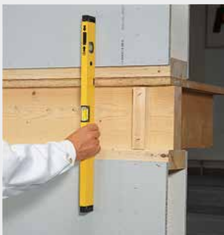
Afbeelding 4.10: Passtellen van de wandelementen
