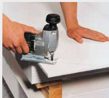
Afbeelding 3.4: Gebruik van de decoupeerzaag voor rondingen en aanpassingen
