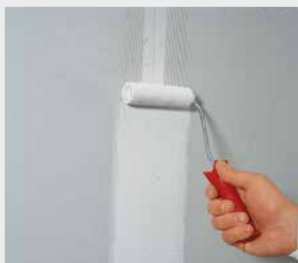
Afbeelding 3.14: Aanbrengen van de fermacell Powerpanel HD Wapeningslijm
