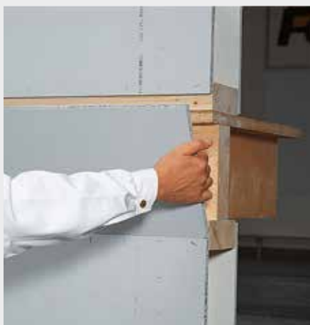
Afbeelding 4.11: Montage van de plaatstroken
