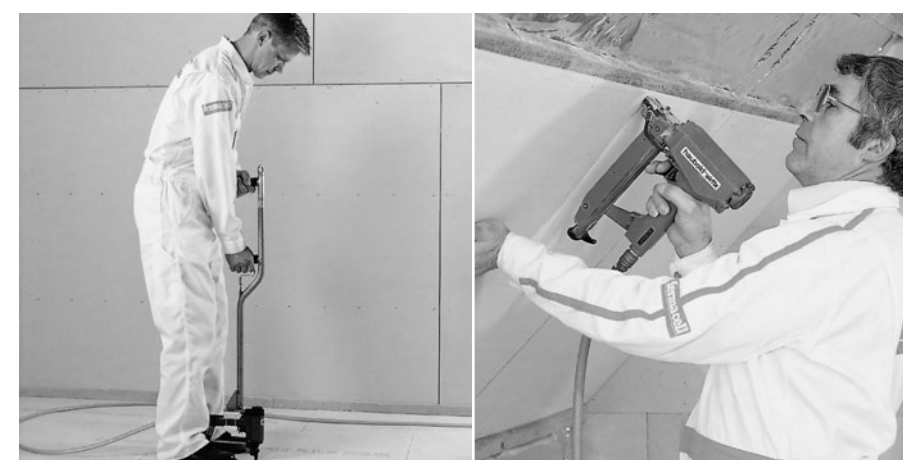
Effectief verwerken van nieten in vloerelementen
