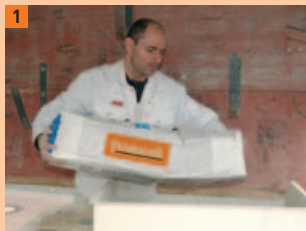
1 Inhoud van een volle zak in de betonmixer aanmaken
