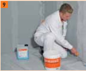
9 FERMACELL Voorstrijk eerst op de vloeraangrenzende wand aanbrengen...
