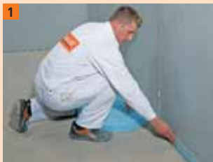
1 Randisolatiestrook aanbrengen
