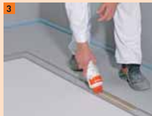
3 Op de liplap van de elementen de FERMACELL vloerelementenlijm aanbrengen
