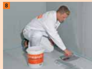
8 Stootvoegen en verbindingmiddel indien nodig met de FERMACELL Powerpanel afwerkmortel afsmeren
