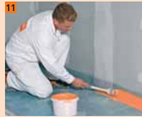
11 FERMACELL Vloeibare folie met een kwast in de hoek aanbrengen
