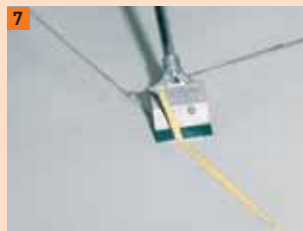
7 Naar buiten gedrukte vloerelementenlijm na het uitharden afsteken
